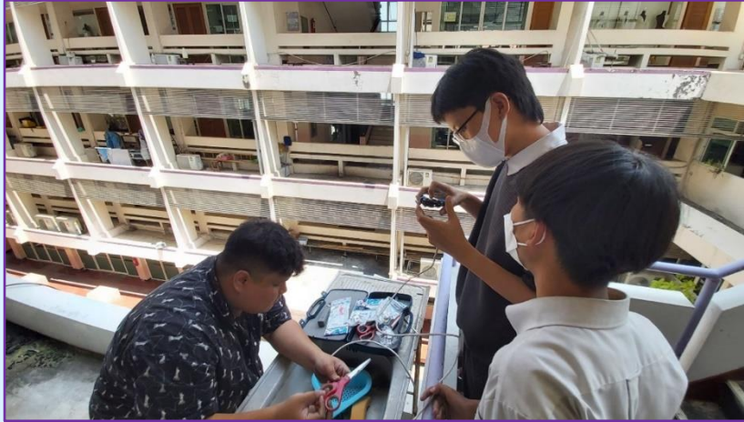
รูปรายงานผลการดำเนินการติดตั้งสายสัญญาณ
