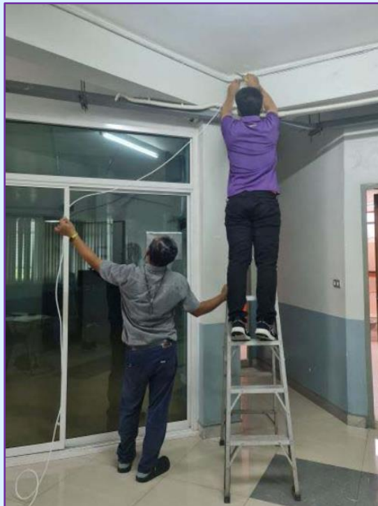
รูปรายงานผลการดำเนินการติดตั้งสายสัญญาณ
